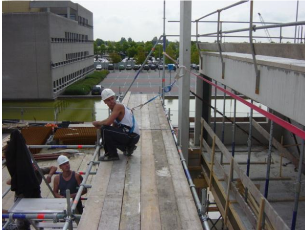
Tijdelijke horizontale valbeveiliging
