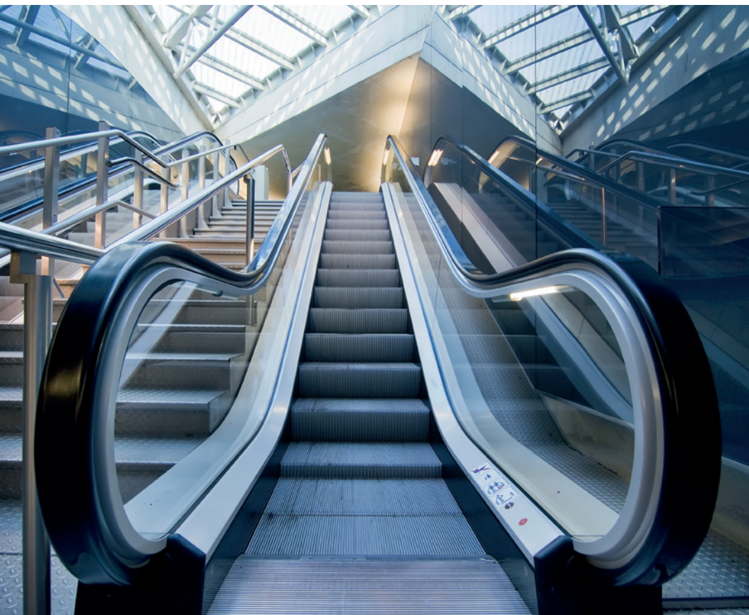
▲ Roltrap in kantoorpand
